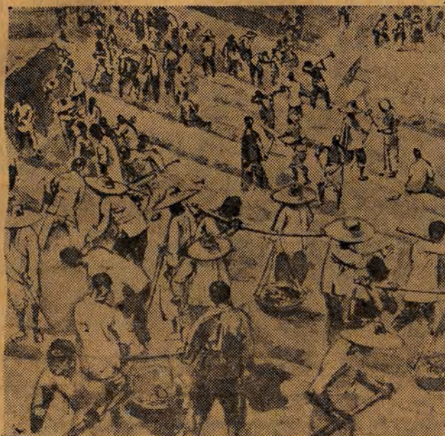
Prace przy regulacji rzeki.
