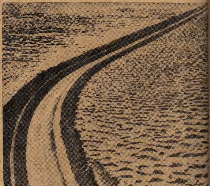
Ein Bild vom Kanalbau zur Bewässerung der Wüstengebet bei Kolorado in den Vereinigten Staaten von Nordamerika. Der Kanal wird 130 Kilometer lang und 86,5 Meter breit
