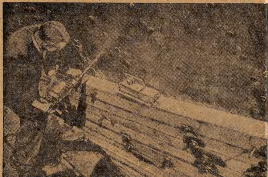
Ein Schiff ohne Bestandteile aus Eisen wird für die englische Marine zu Studienzwecken gebaut, um die magnetischen Einflüsse der Erde zu überprüfen
