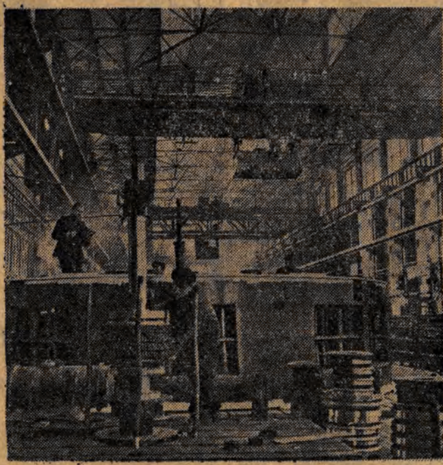
Fabryka „Uralkalochim” w Sverdłowsku produkuje potężne maszyny elektryczne. NA ZDJĘCIU: montaż statoru hydrogeneratora dla Kamskiej Elektrowni Wodnej. Fot. — CAF
