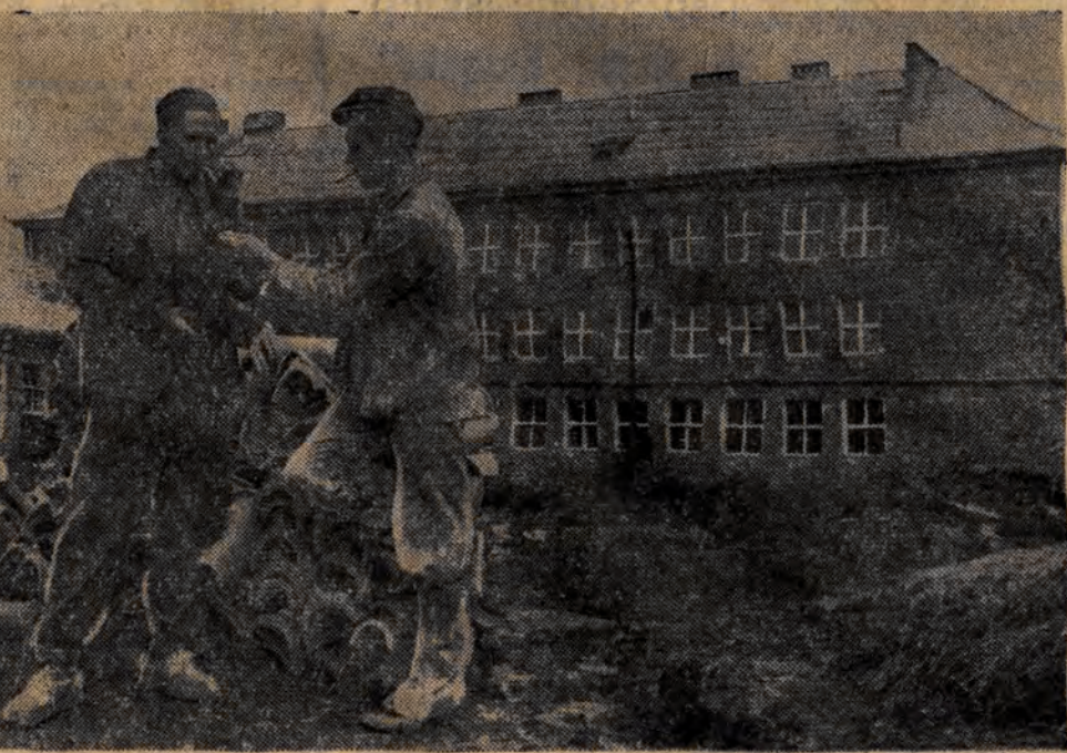
Dzięki realizowanym zobowiązaniom na cześć 10-lecia Polski Ludowej nowoczesny budynek szkolny przy ul. Niciarnianej zostanie przed terminem oddany do użytku. NA ZDJĘCIU: na lewo nowo wybudowane szkoły widoczne przy budownictwie — betoniarz Stanisław Mrowiński i graczyni Stanisław Dembski, którzy wykonując przeciętnie 200 proc. normy dali duży wkład pracy w realizację zobowiązań podjętych przez załogę ZBM.
