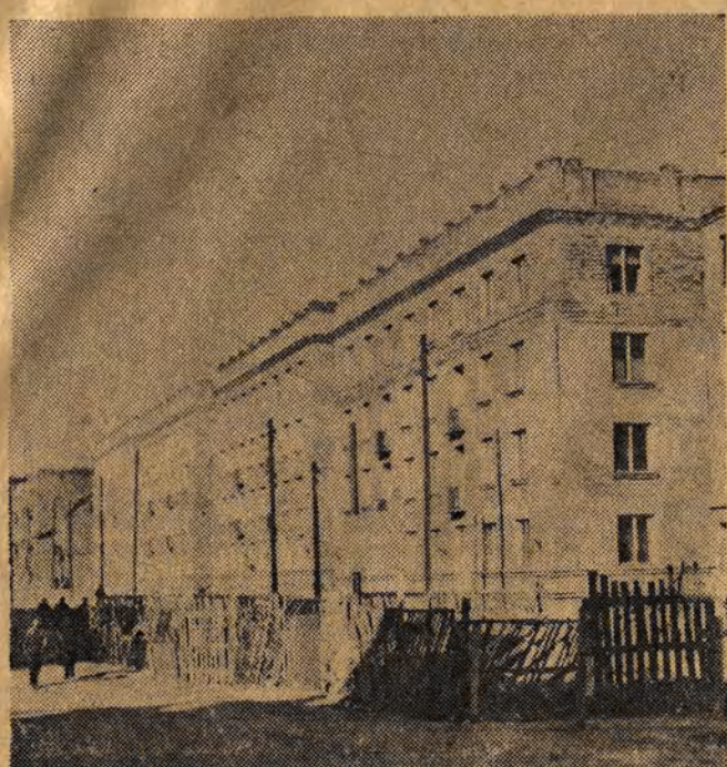
Białystok, jedno z najbardziej zaniedbanych miast sanacyjnej Polski „B”, przybiera nowe oblicze. NA ZDJĘCIU: fragment nowoczesnego osiedla robotniczego przy ul. Kupieckiej.
