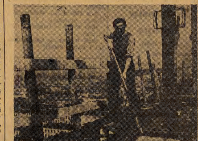
Zbrojarz Mietek Kosiorowski przygotowuje więzania stropów nad 13 piętrem wieżowca. Fot. — A. J.
