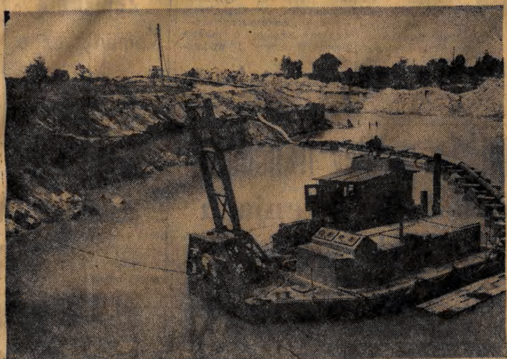
Budowa zapory wodnej w Goczałkowicach
