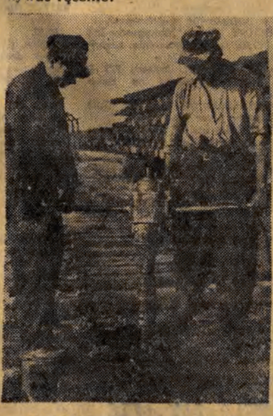
Ta elektryczna nakrętnica, kierowana ręką robotników, przykręca 7 wkrętek na minutę. Fot. A. J.
