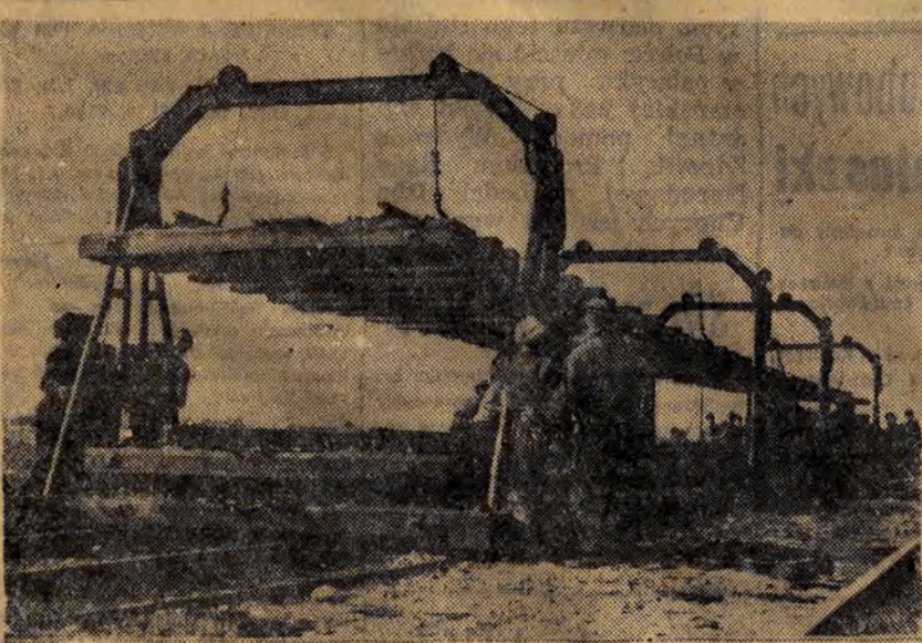
Montaż prześła ukończony. 4 dźwigi bramiaste idą w ruch. Unoszą jak pióro 30-metrowe prześło, które wkrótce znajdzie się na szlaku kolejowym. Fot. A. J.
