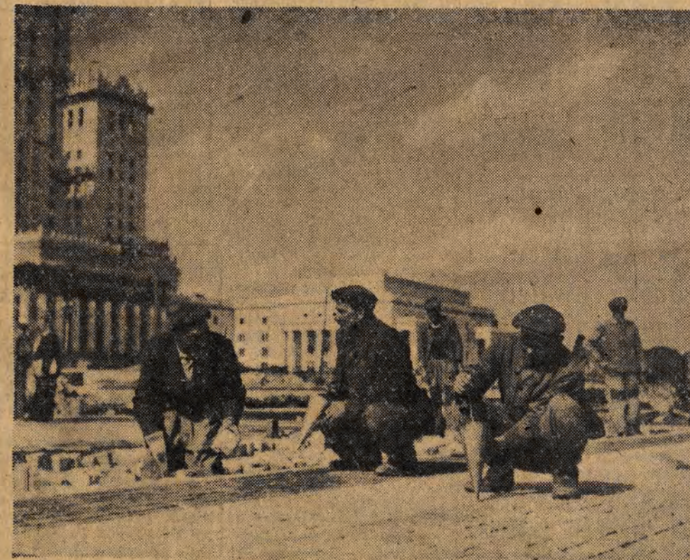
Na pl. Stalina w Warszawie trwają intensywne prace przy układaniu mozaikowej nawierzchni placu. Mozaika układa się z kolorowych kostek bazaltu, porfiru i granitu. NA ZDJĘCIU: prace na pl. Stalina na pierwszym planie brukarz W. Jóźwiak i ubijacz: St. Borkowski i J. Dmoch. CAF — fot. Miedza
