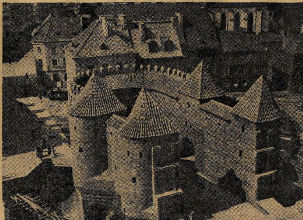
Barbakan i odbudowane domy na Nowym Młódzu w Warszawie.
