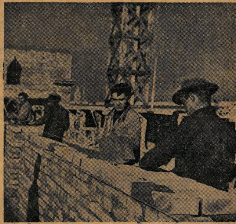
Na Mokotowie w Warszawie, na terenie budowy prowadzonej przez Zjednoczenie Budownictwa Miejskiego nr 5, odbywa się szkolenie murarzy w zastosowaniu nowych radzieckich metod pracy. Młodzieżowa, ZMP-owska brygada murarska Leona Chmielarskiego, stosując metodę Szyszmira i Zawitowa już w pierwszym dniu pracy osiągnęła 182 proc. normy. NA ZDJĘCIU: brygada Chmielarska przy pracy. CAF — fot. Pienkowski
