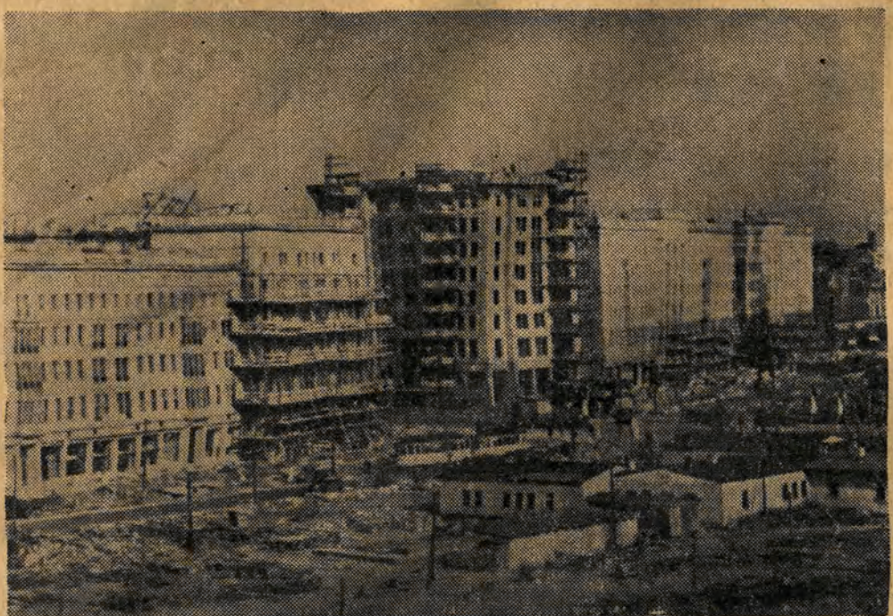
Rząd NRD przeznaczył na budowę trasy Wschód — Zachód w Magdeburgu 15 milionów marek. Obecnie strona północna tej trasy jest gotowa w stanie surowym. NA ZDJĘCIU: fragment budowy trasy Wschód — Zachód.
