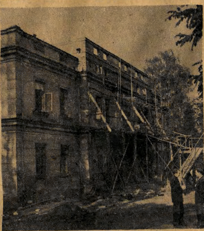
Budownictwo w Zespole PGR Strzałków, woj. łódzkie. NA ZDJĘCIU: budowa hotelu robotniczego dla pracowników sezonowych.
