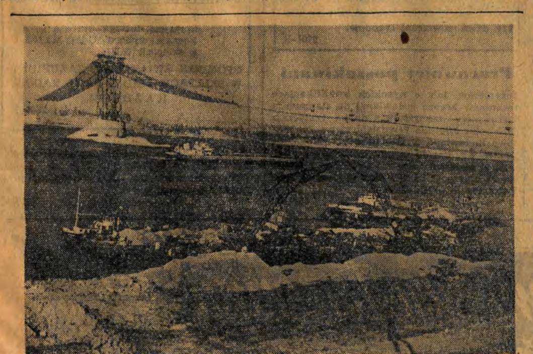
Na budowie Kujawskiego Elektrowni Wodnej trwają prace, mające na celu przeprowadzenie koryta Wisły na dno rzeki zrujnowanej przez setki tysięcy kamienia. Na prawym brzegu buduje się tamę ziemną przylegającą do budynku elektrowni. NA ZDJĘCIU: wyładowanie ziemi, przeznaczoną na budowę tamy ziemnej.
