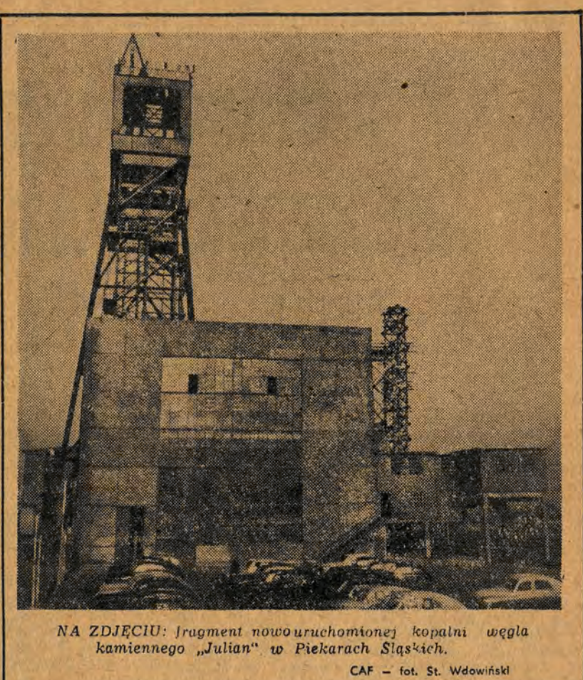
NA ZDJĘCIU: fragment nowouruchomionej kopalni węgla kamiennego „Julian” w Piekarach Śląskich. CAF — fot. St. Wdowiński
