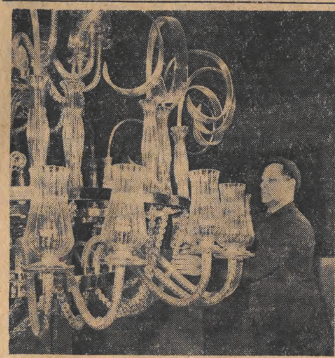
Prace w gmachu Filharmonii Warszawskiej weszły w ostatnie stadium. NA ZDJĘCIU: montaż zgranda w sali koncertowej. Przy pracy Bolesław Mazurek.
