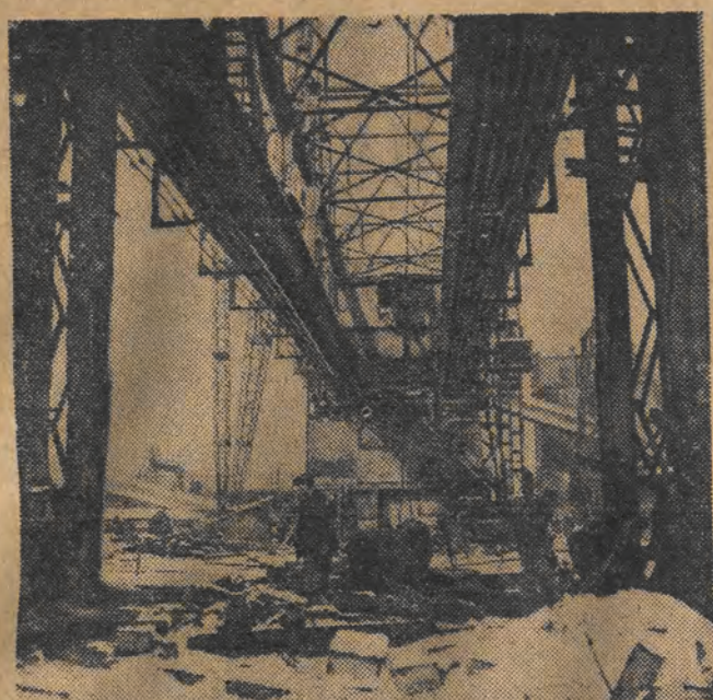
NA ZDJĘCIU: układanie torów pod mostem przelazkowym w rejonie koksoschematu.
