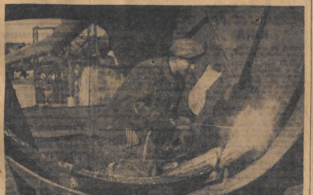
NA ZDJĘCIU: Kazimierz Dulewicz spawa część połączeniową odpalacza dla II pieca.
