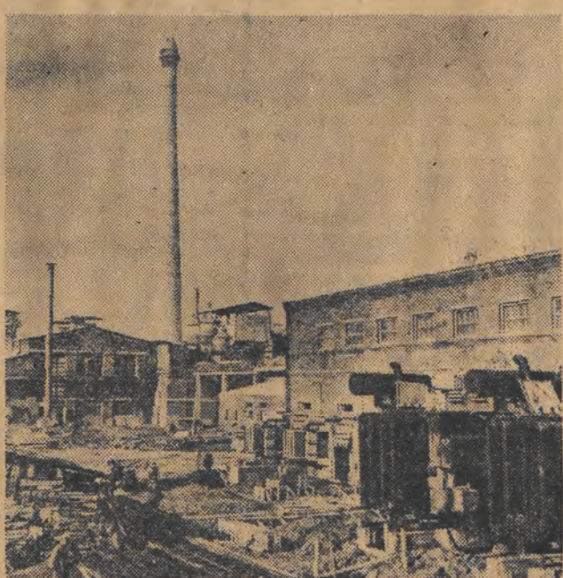
Szybko postępuje budowa pierwszych w Bułgarii zakładów hutniczych kolorowej metalurgii. NA ZDJĘCIU: widok terenu budowy.
