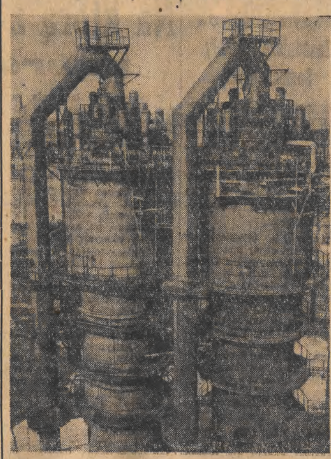
Już niedługo ruszy wielki piec nr II. Obecnie trwają intensywne prace nad wykończeniem poszczególnych obiektów wielkiego pieca. Skip, hala leżniowa i elektrofilytry są już gotowe. Dzięki zobowiązaniu brzożyci Józefa Piłki z Mostostalu w dniu 17. III na trzy dni przed terminem smontowano gazociąg gazu wlotkowego. Waży on „tylko” 55 ton.
