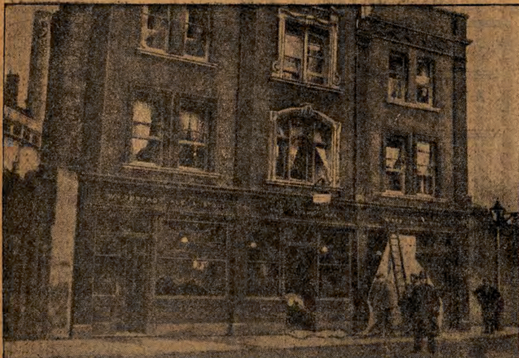
Ein Haus im Londoner Stadtviertel Southwark, in dem alle Fenster Scheiben infolge der Bombenexplosion bei dem in der Nähe gelegenen Elektrizitätswerk herausflogen
