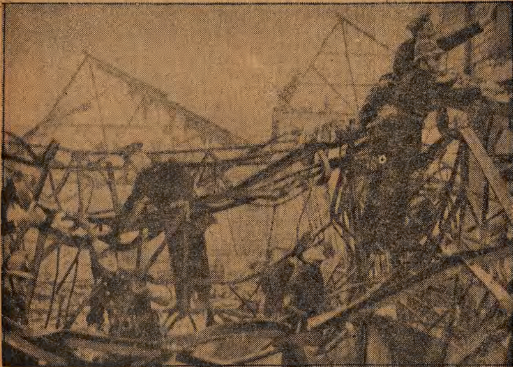
Bombenfabrikation oder Betriebsunfall? Bei dem Brand einer großen Fabrik in Slough in Buckinghamshire kam es zu Explosionen. Die Polizei nimmt deshalb an, daß es sich auch hier um ein Attentat der Terroristen handelt, die ganz England in Anfechtung versetzen
