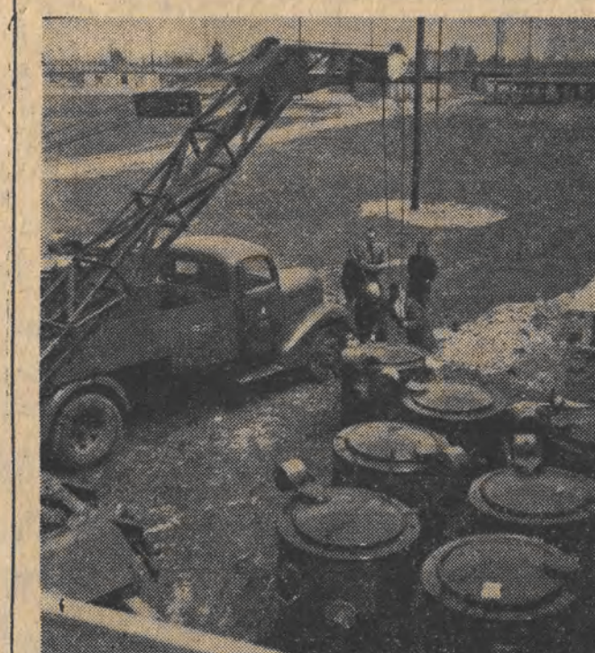
Budowniczości Ministerstwa Festiwalowego na Grochowski pracują w ście „Warszawskim temple”. Do chwili obecnej wykonano już 75 proc. ogółu prac związanych z budową stadionu, 25 maja na teren stadionu przywieziono nowiutkie kuchnie.
