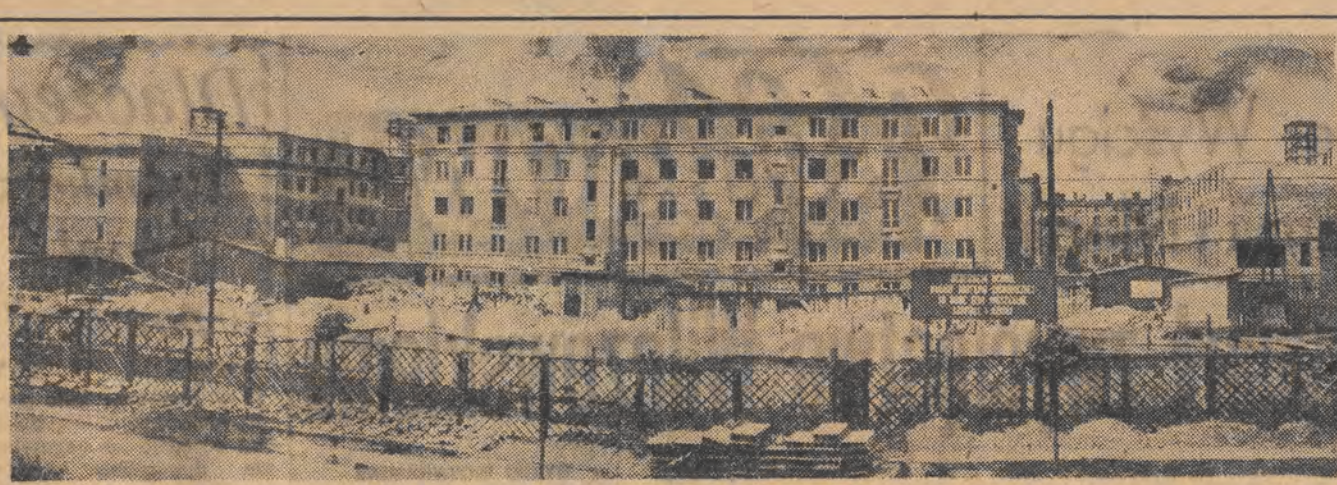
Przy ul. Zachodniej w Łodzi wyrósł dalsze bloki. Mimo że budowę ich rozpoczęto dopiero zimą, już wkrótce oddane zostaną do użytku. A więc tempo naprawdę imponujące. Szybkości budowy musi jednak towarzyszyć większa troska o staranne wykończenie izb.
