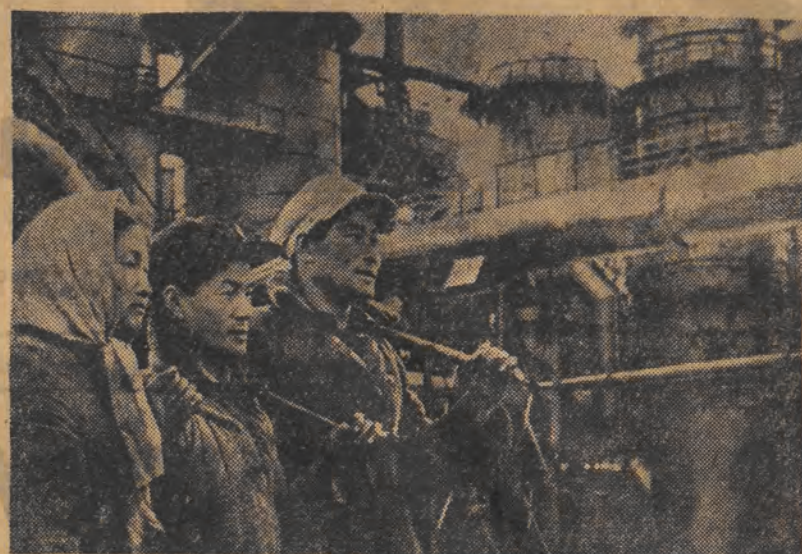
Odbudowane zakłady metalurgiczne Kim Chaik w Koreańskiej Republice Ludowo-Demokratycznej.
