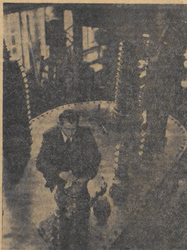
Takie oto kolosy wychodzą z zakładów M-3. Dwaj zetemowcy Andrzej Smoliński i Stefan Królikowski pracują przy montażu transformatora.
