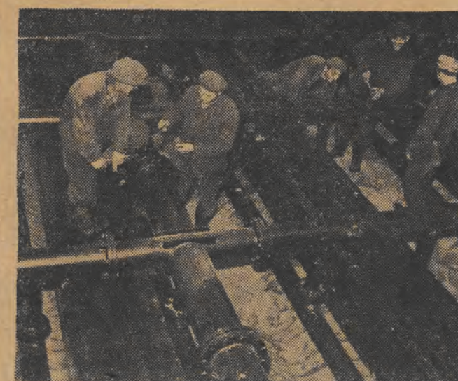
ZDJĘCIE POWYŻEJ: ostatni ruch kluczem i stacja filtrów gotowa.
