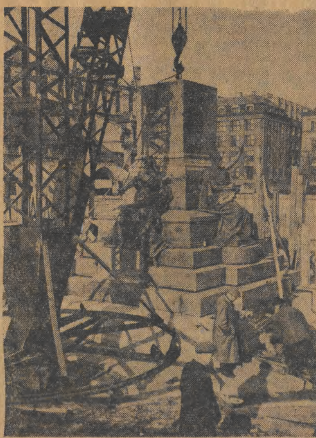
Prace przy montowaniu pomnika Adama Mickiewicza na Ryńku Głównym w Krakowie dobiegają końca. 19 bm. nastąpiły próby ustawienia figury na cokole. Figury alegoryczne zostały już ustawione. Obecnie odbywa się ich umiędziawienie i patynowanie.
