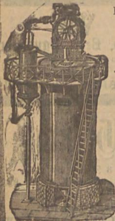
**Apparat für Reinigung und Weichmachung des Wassers**
