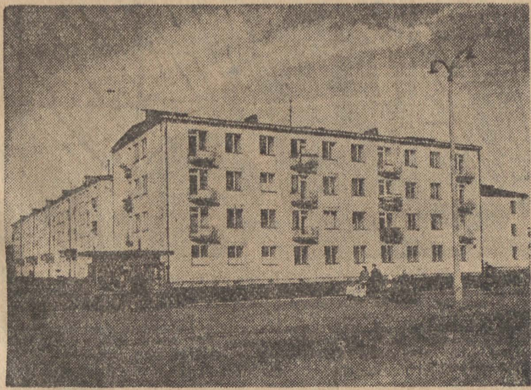
Budowę osiedla mieszkaniowego Mokotów rozpoczęto w kwietniu 1948 roku. Do chwili obecnej jest już zamieszkałych dwa i pół tysiąca mieszkańców. W styczniu bieżącego roku odda się do użytku dalszych 60 mieszkań. Na zdjęciu: Fragment osiedla mieszkaniowego Mokotów. CAF — fot. Zygm. Wdowiński
