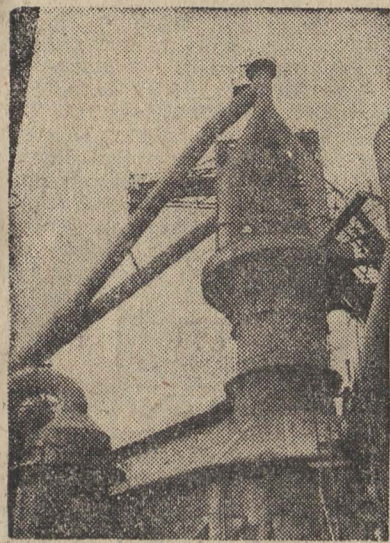
Huta „Kościuszko” w ramach Planu 5-letniego podlega dalszej rozbudowie i unowocześnieniu. Niedawno uruchomiono nowoczesny wielki piec „B”. Obecnie prowadzone są intensywne prace przy budowie następnego w kolejki szkieletu człowieka prehistorycznego. Na zdjęciu: fragment nowowbudowanego wielkiego pieca „B”. CAF fot. St. Wdowiński
