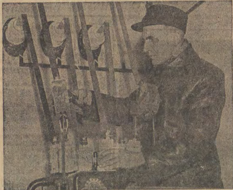
W ramach Planu 6-letniego powstaje w Kędzierzynie wielki kombinat przemysłu azotowego. Na budowie jest szeroko rozwinięta akcja socjalistycznego współzawodnictwa pracy oraz ruch racjonalizatorski.
