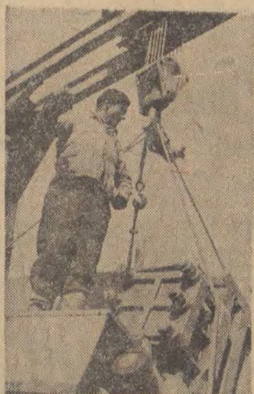
Przy budowie Cementowni w Wierzbicy trwają gorączkowe prace przed majowym się odbyć uruchomieniem wielkiego obiektu Planu 6-letniego. Na zdjęciu: Zygmunt Borkowski z uwagą kieruje pracą dźwigu przy budowie kruszarni.
