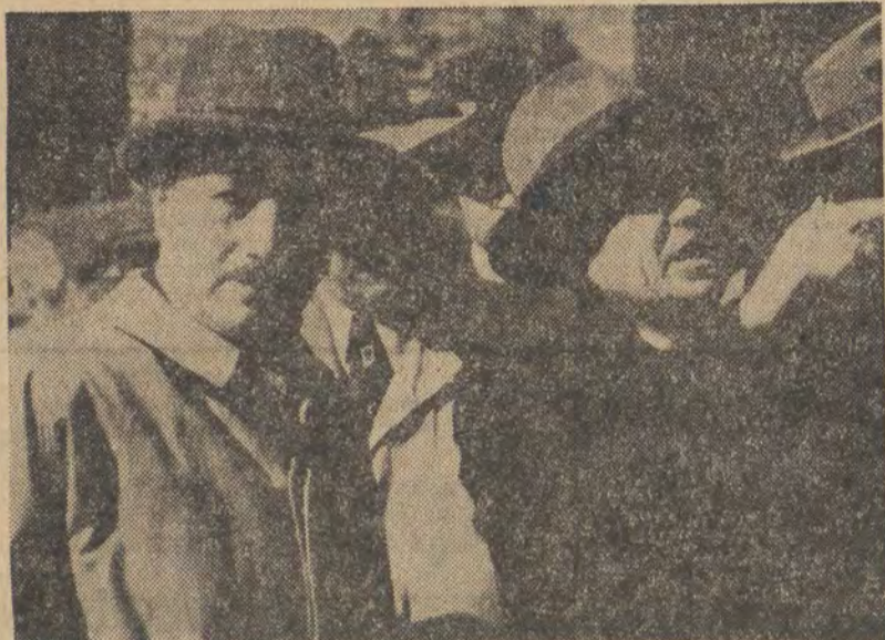
Prezydent RP Bolesław Bierut świdczą budowę mostu Śląsko - Dąbrowskiego podczas ustawiania pierwszych przęseł (1948 r.).
