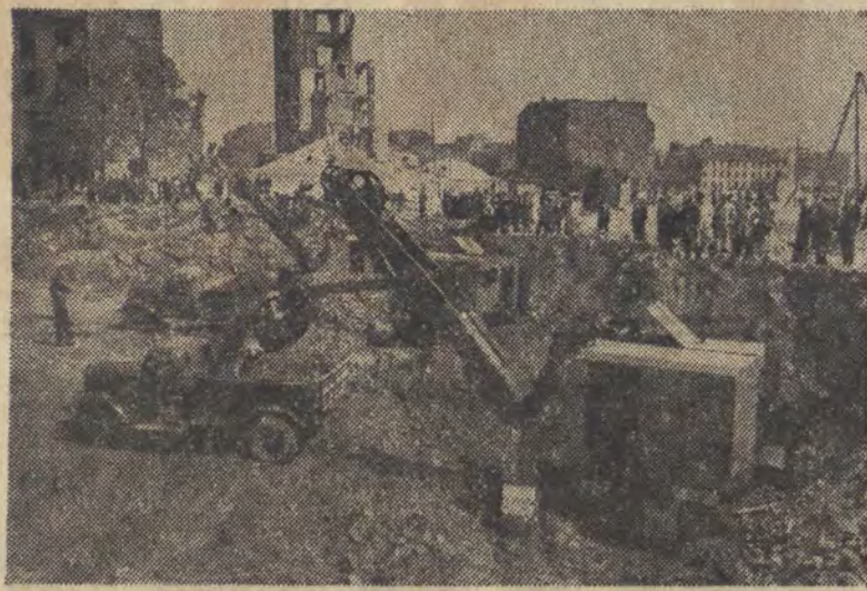
Na olbrzymim placu budowy Pałacu Kultury i Nauki, oczyszczonym już częściowo z ruin, pomiędzy ulicami Złota i Sienka, wrę przyspieszona praca przy pomocy zmechanizowanego sprzętu: nowoczesnych koparek, spychaczy i sprzężarek radzieckich. Na zdjęciu: fragment prac przy ul. Złotej. CAF — fot. Barano vski.
