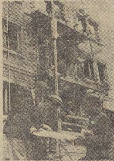
Brygada ciesielska z Muranowa w Warszawie pracująca na odcinku „C” pod kierownictwem Z. Leśniewicza, wykonująca przedterminowo zadania Planu 6-letniego.
