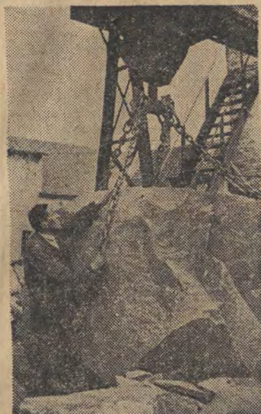
Załoga Zakładów Kamienia Budowlanego w Piławie na Dolnym Śląsku pracuje obecnie pełną parą dla Warszawy — dla MDM — produkując marmurowe i granitowe stopnie, balustrady, okładziny, odrzwia, wnętrza sklepów itp. Na zdjęciu: majster Zdzisław Chyżyński — starszy traktor — przy transporcie olbrzymiego bloku granitowego wagi kilkunastu ton.
