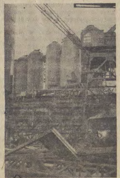
Po zimowych pracach przy budowie fundamentów przystąpiono obecnie do montażu konstrukcji stalowej wielkiego pieca „C”.
