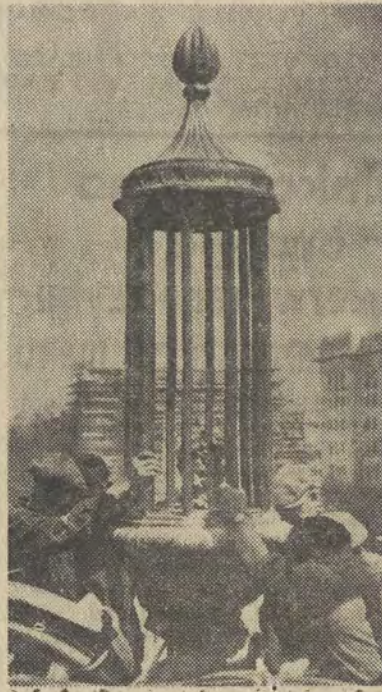
Na zdjęciu: brygada monterów Eugeniusza Zielińskiego zakłada latarnie na ramiona kandelabru. CAF — fot. Szyperko
