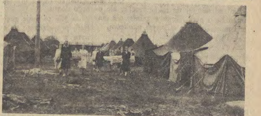
W miasteczku złotowym na Grochowie ustawiono już namoty. Ochotnicze brgady młodzieżowe pracują przy porządkowaniu terenu. Na zdjęciu: uczennice Technikum Finansowego nr 2 w Warszawie, przy pracy. CAF — fot. Zvem. Wdowiński.
