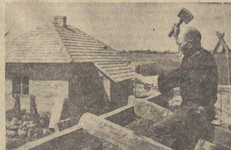
Członkowie Rolniczego Zespołu Spółdzielczego w Plackiej Dąbrowie rozpoczęli na swych działkach przyzagrodowych budowę pomieszczeń gospodarskich. Umożliwi im to rozwiniecie hodowli bydła, trzody i drobiu. Na zdjęciu: Jan Karasiewicz buduje oborę na swojej działce przyzagrodowej. CAF — fot. Tymniński.
