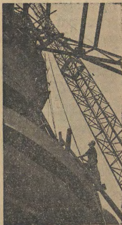
W szybkim tempie posuwają się prace przy budowie Wielkiego Pałacu „C” w hucie „Kościuszkowski”. Na zdjęciu: fragment budowy Wielkiego Pałacu „C”. CAF — fot. Tymiański
