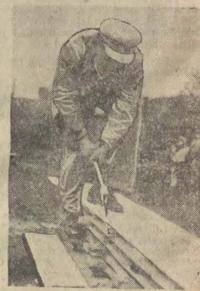
A Zdzisław Musiałowicz, cieśla pracujący przy budowie nowej szkoły na ul. Wólczańskiej 190, powiedział po prostu:
