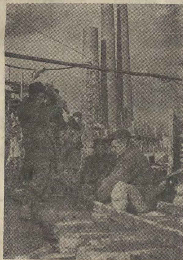
Mimo okresu zimowego, tempo budowy cementowni Rejowice nie słabnie. Ostatnio przy budowie kominów prowadzone są już prace wykończeniowe. W trakcie budowy znajdują się wielkie żelbetonowe silosy, zaś w hali oddziału węglowego zespoły robotników montują już pierwsze urządzenia. Na zdjęciu: przodująca brygada Jana Staszczaka układa tory kolejki wąskotorowej dowożącej materiały budowlane. CAF — fot. St. Wdowiński.
