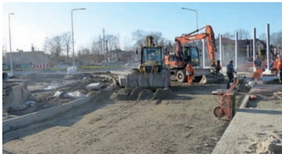
Trwa budowa wjazdu na os. Konopniczej.
