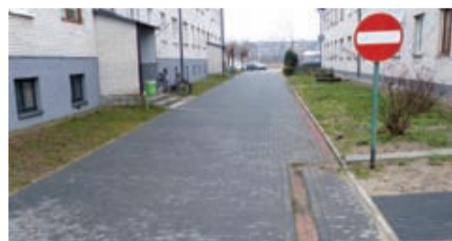
Od kiedy droga między blokami jest jednokierunkowa, sytuacja bardzo się poprawiła, ale jednak wyjście z klatki bloku 1B (na zdjęciu po lewej stronie) nadal nie jest do końca bezpieczne.
