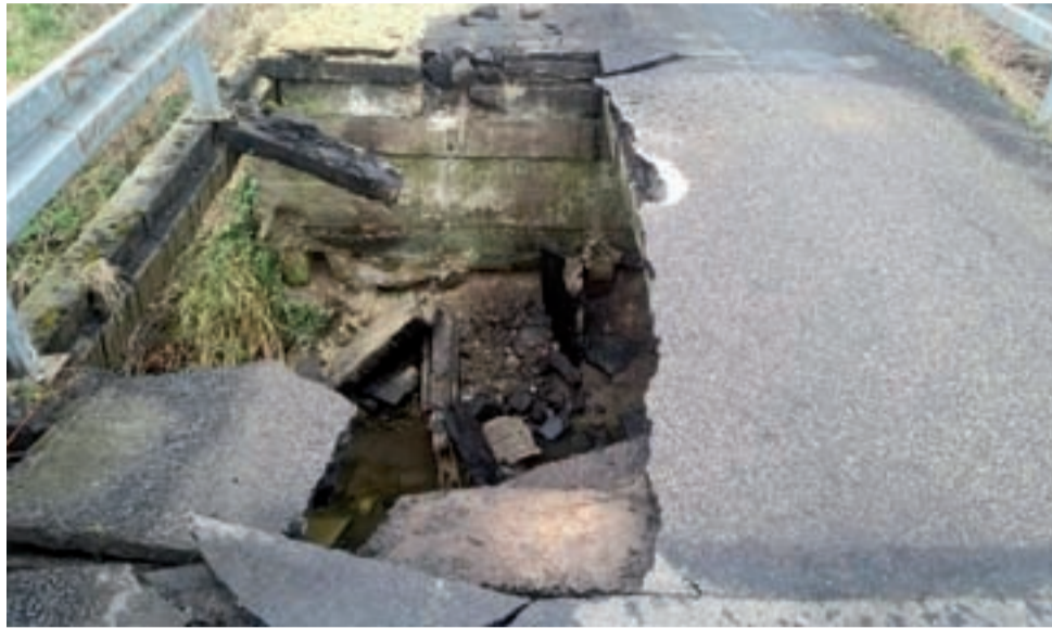
Zarwany most w na ul. Spacerowej w Bednarach. Połowa legła w korycie przepływającej pod nim strugi.
