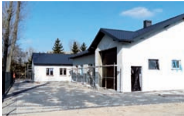
Budowa Gminnego Domu Kultury w Chąśnie Drugim nadal trwa.
