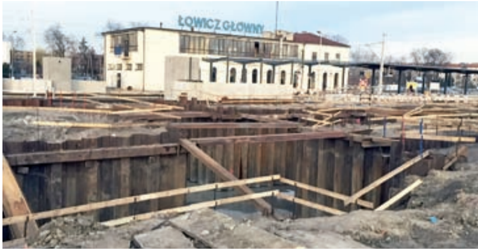
Bez tych stalowych ścian prace w głębokim wykopie pod przejście podziemne nie mogłyby się odbywać.
