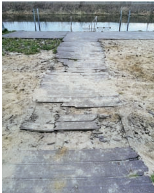
Zniszczony pomost wiodący do przystani kajakowej.
