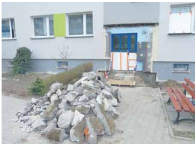
Poza dociepleniem elewacji, ŁSM zleciła wykonawcy wykonanie dodatkowych prac, które dobiegają końca.
