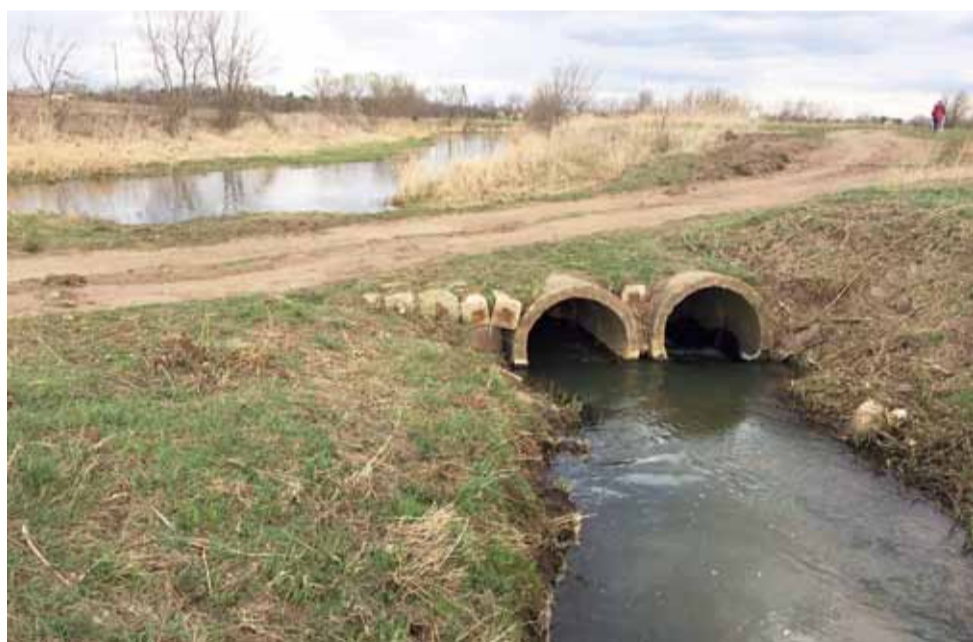
Ujście Otolanki do Bzury.
