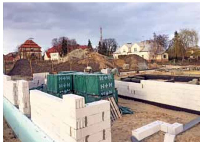
Przed kilkoma dniami mury pierwszych domów zaczynały być już widoczne ponad ziemią.
