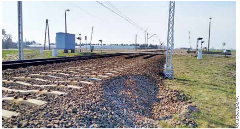
Zdemontowane szyny przy przejeździe na ul. Płockiej. Ruch w stronę Kutna odbywa się na jednym torze.
