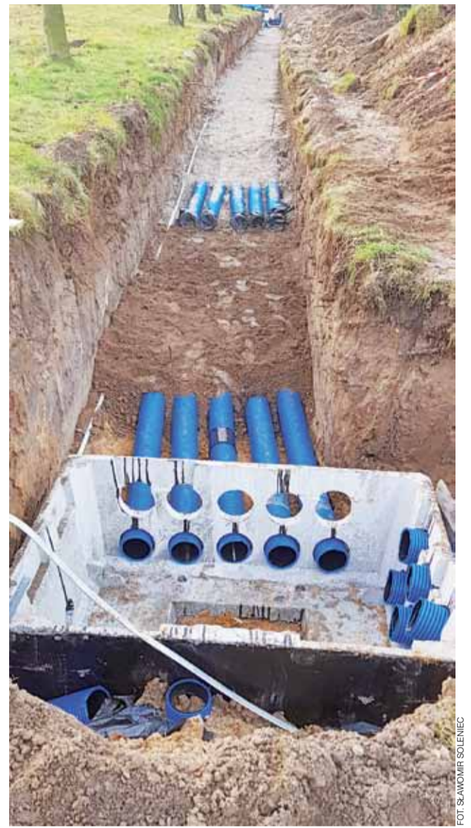
Kanalizacja kablowa jest już gotowa w ok. 40%.
