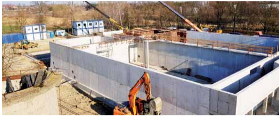
Kończenie betonowania konstrukcji ścian komór predenitryfikacji, defosfatacji i denitryfikacji.
